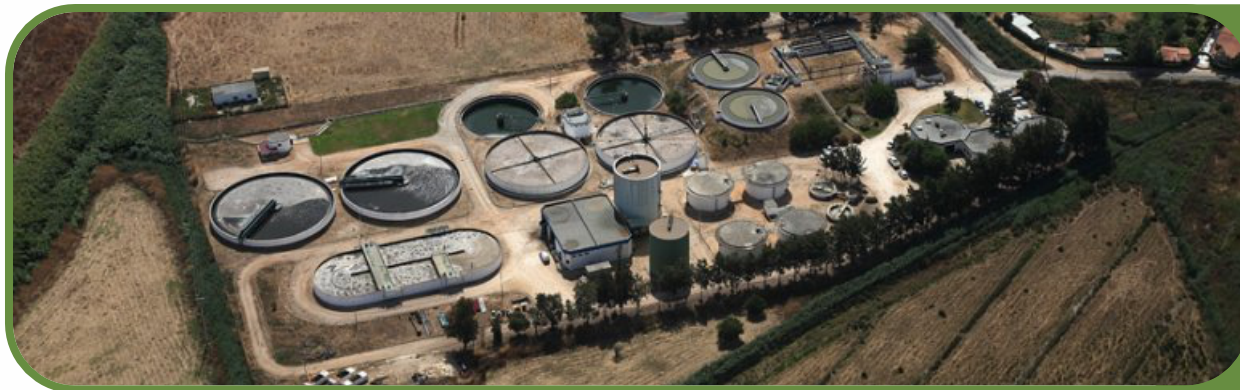
Fig. 1: Imagem aérea da ETAR de Lagos
